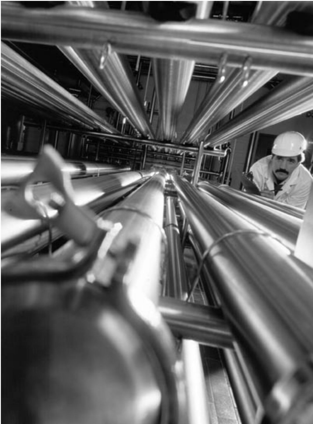
En haut et à droite : Un système d'ultrafiltration continu sépare les protéines du lait et les sucres. Source : Commission canadienne du lait
